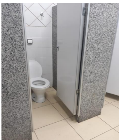
Figura 37 - Boxe do banheiro comum.
