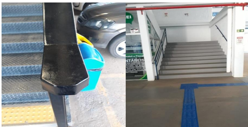
Figura 33 - Corrimões de escada de acesso aos anexos superiores. Fonte: Gonçalves, 2018
