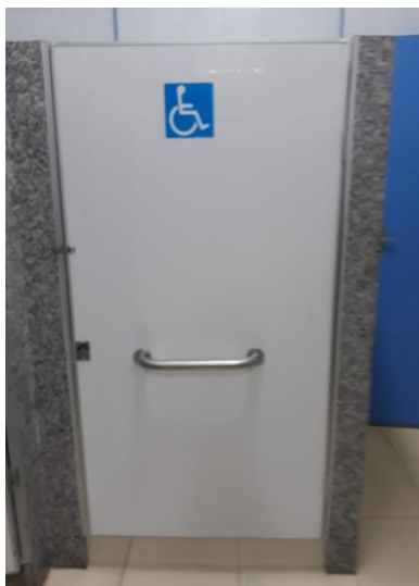
Figura 38 - Boxe com símbolo internacional de acesso para pessoas com mobilidades reduzidas.
