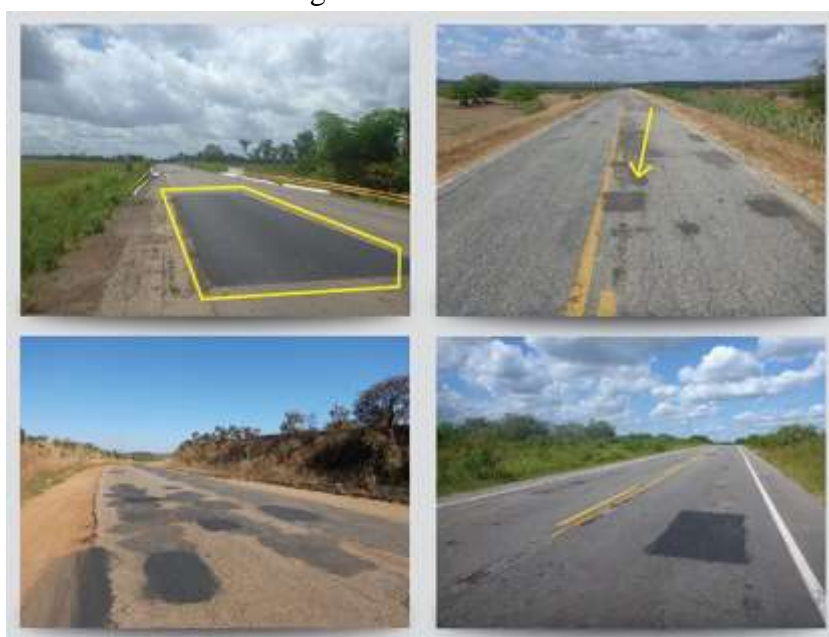
Figura 18 - Remendo.
