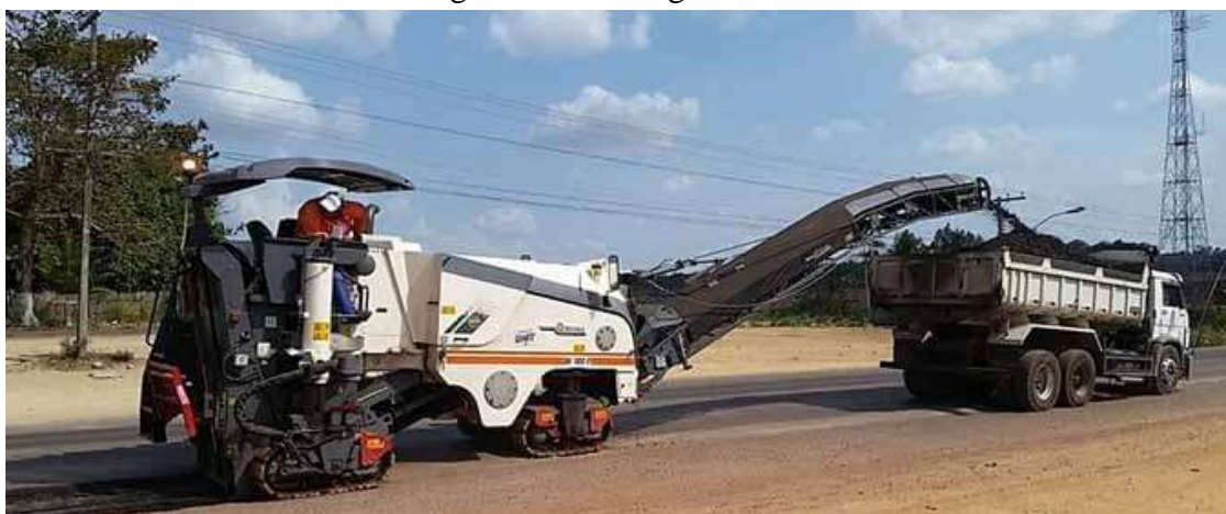
Figura 30 – Fresagem a frio.
