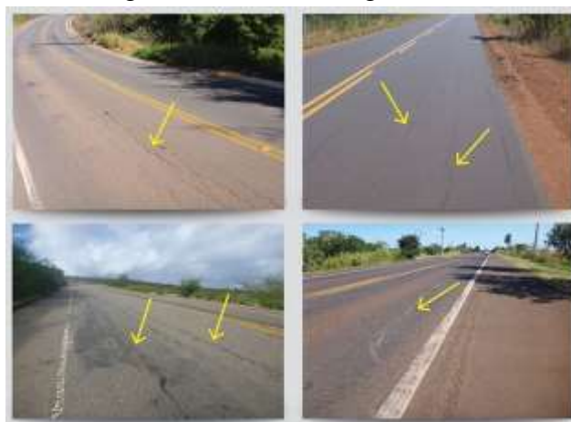
Figura 8 - Trincas Longitudinais.
