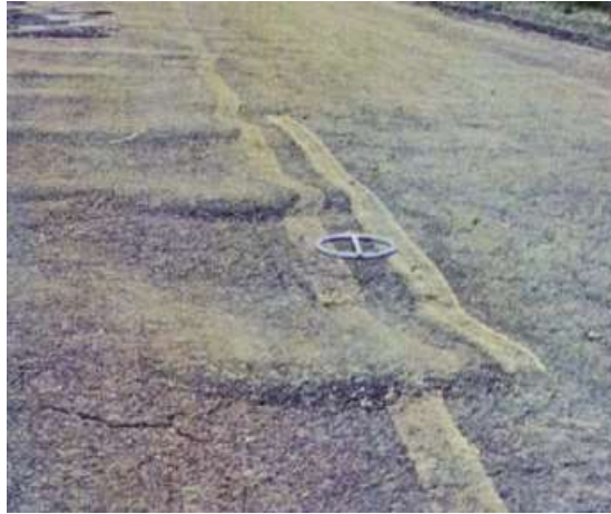
Figura 13 - Ondulação / Corrugação.
