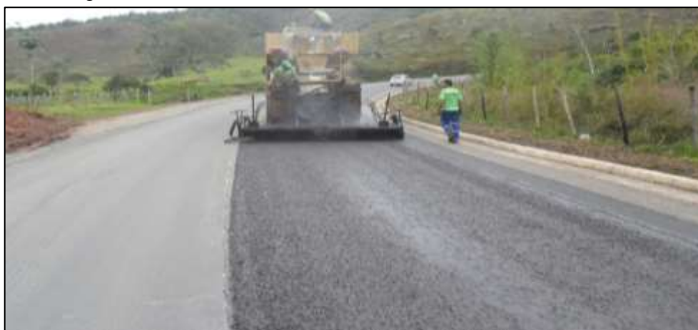
Figura 27 – Microrrevestimento Asfáltico a Frio com Emulsão.
