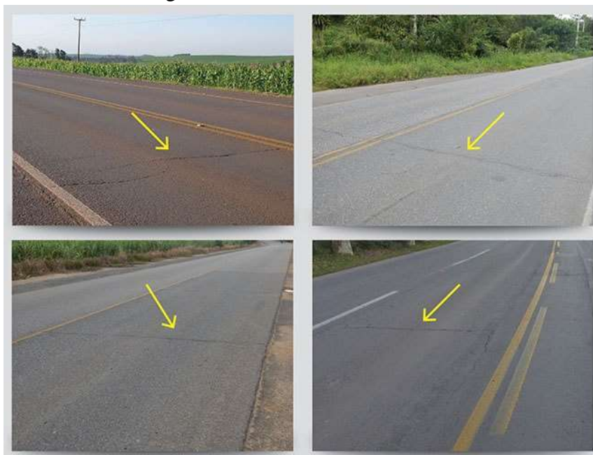
Figura 7 - Trincas transversais.
