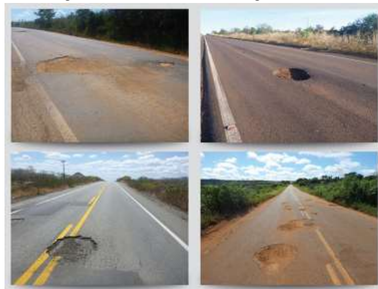
Figura 17 - Panela e Panela atingindo a base.
