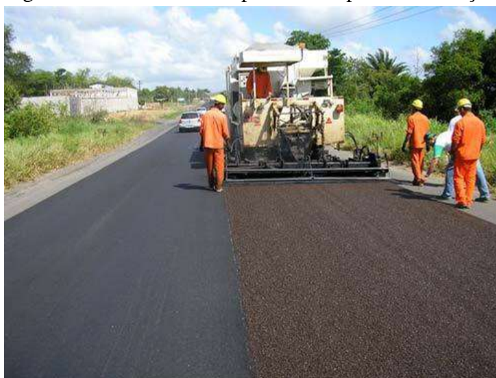
Figura 26 – Tratamento Superficial Duplo em Execução.
