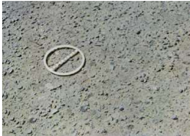
Figura 16 - Desgaste do Pavimento Flexível.
