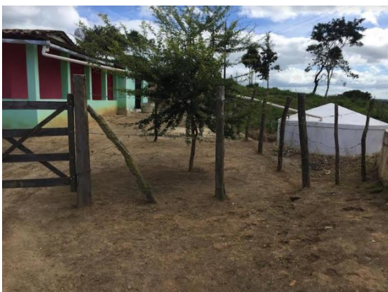
Figura 13- Cisterna com sistema de calhas em Garanhuns.
