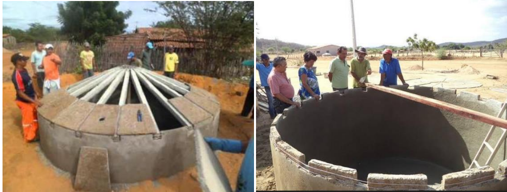
Figura 14- Construção de Cisterna.
