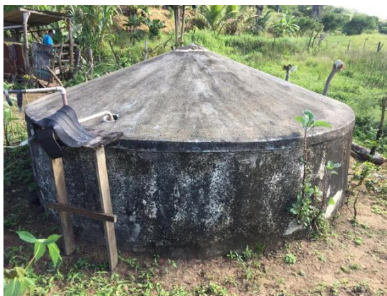
Figura 12- Cisterna de placa de concreto em Garanhuns.
