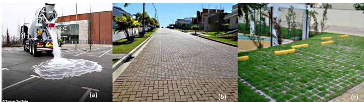
Figura 1 - Modelos de pavimentos permeáveis. (a) Asfalto Poroso (b) Concreto Poroso (c) Concreto Perfurado
