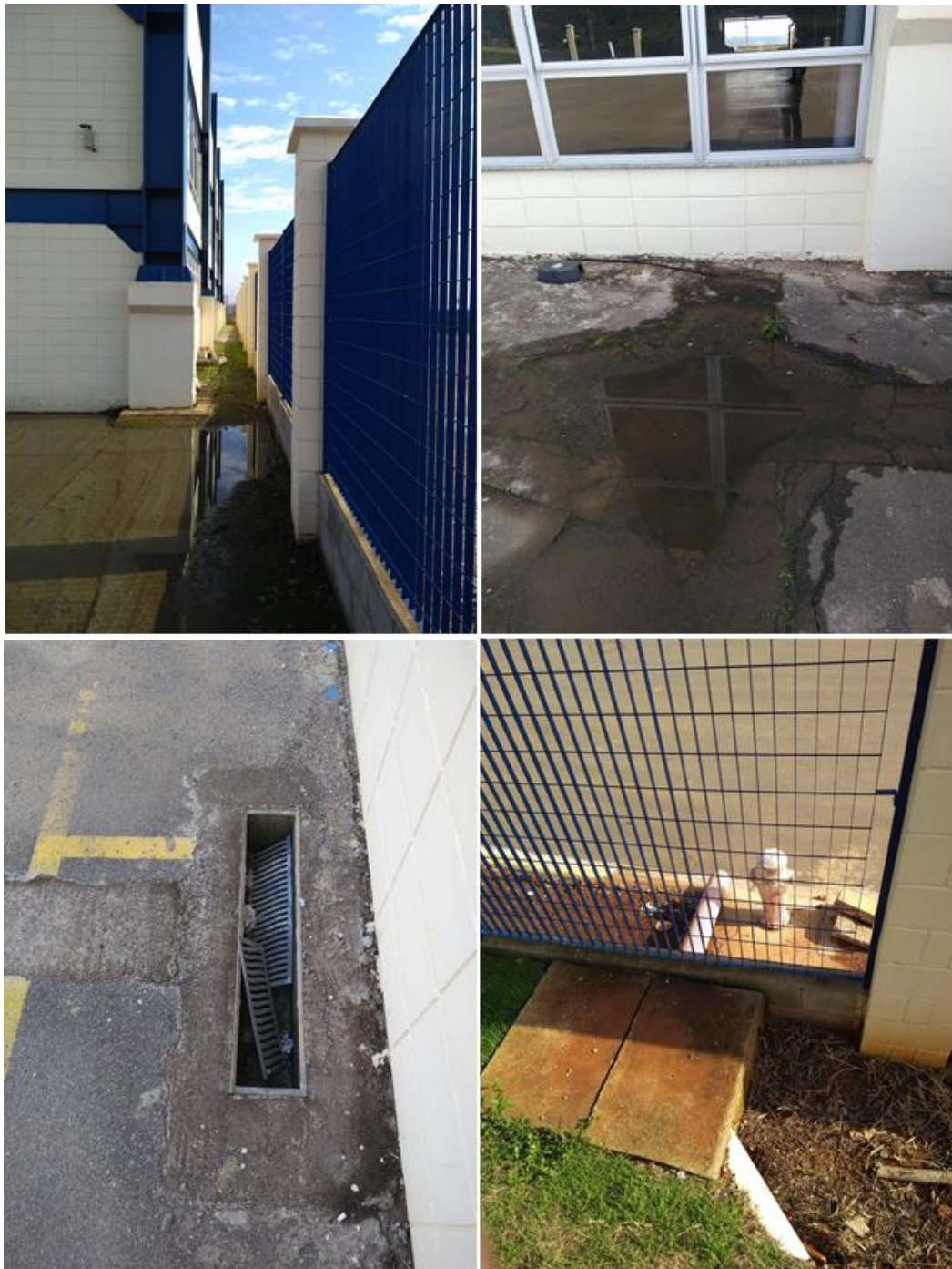
Figura 18– Sistema de drenagem existente
