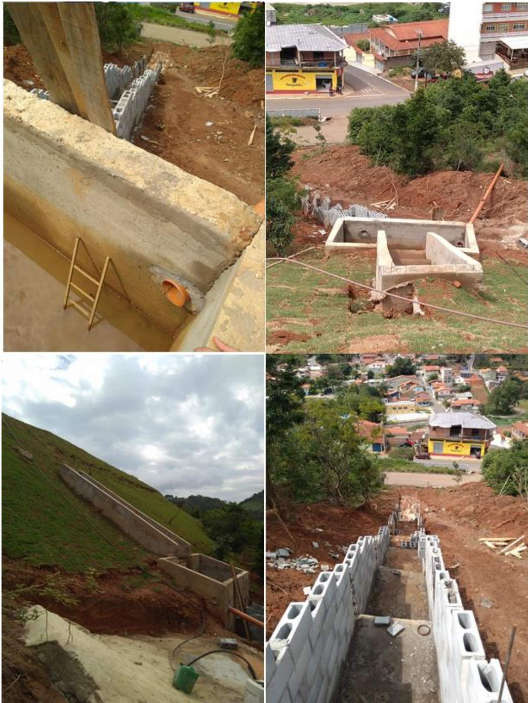
Figura 19 – Sistema de drenagem existente
