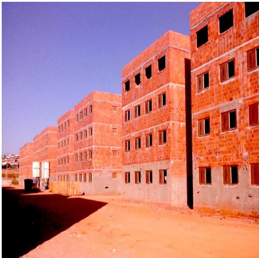
**Figura 22: Construção em Bloco Estrutural Cerâmico**
