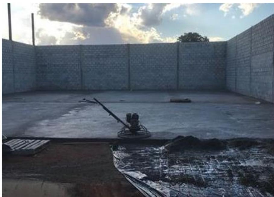
**Figura 13: Construção sem paredes de contraventamento**
