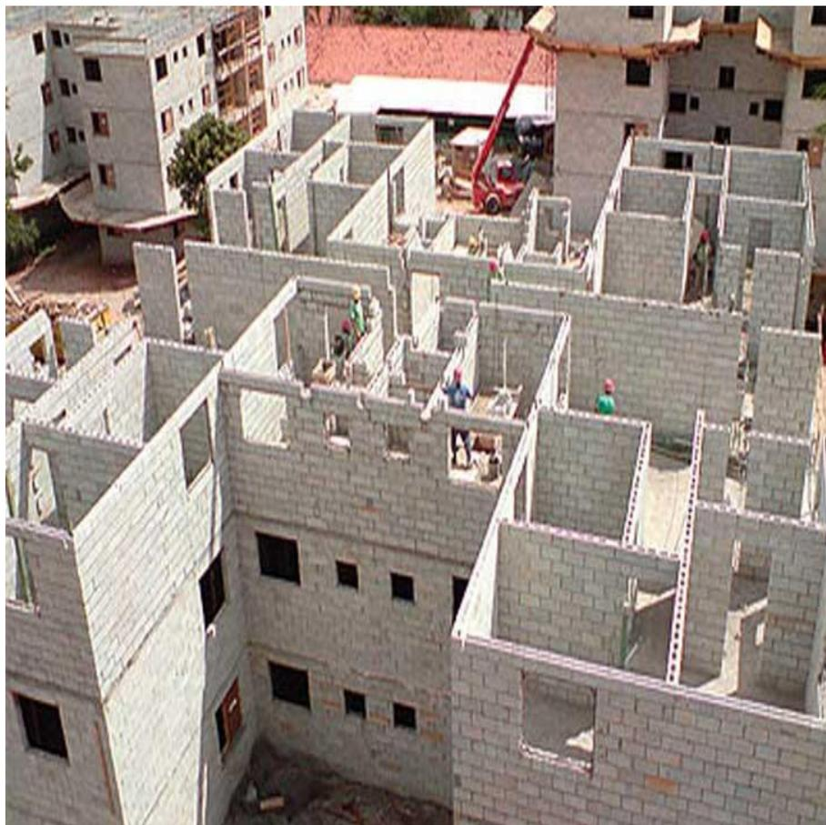
**Figura 14: Construção com paredes de contraventamento**
