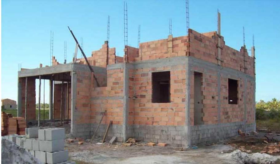
**Figura 1: Alvenaria Convencional**
