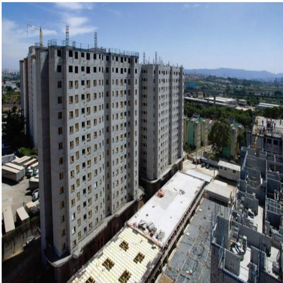
**Figura 21: Construção em Bloco Estrutural de Concreto**
