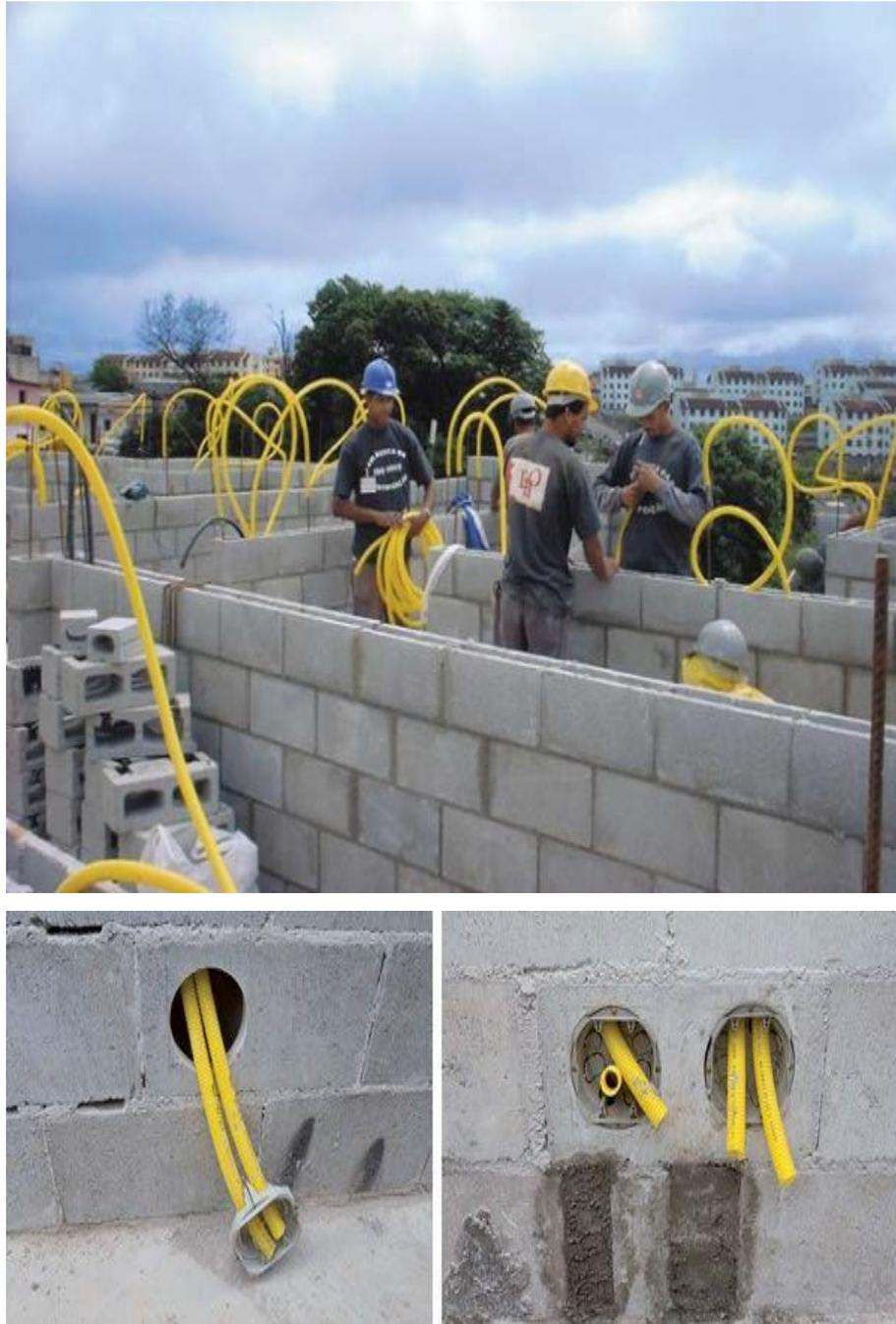
**Figura 18: Passagem das tubulações elétricas pelos furos dos blocos**
