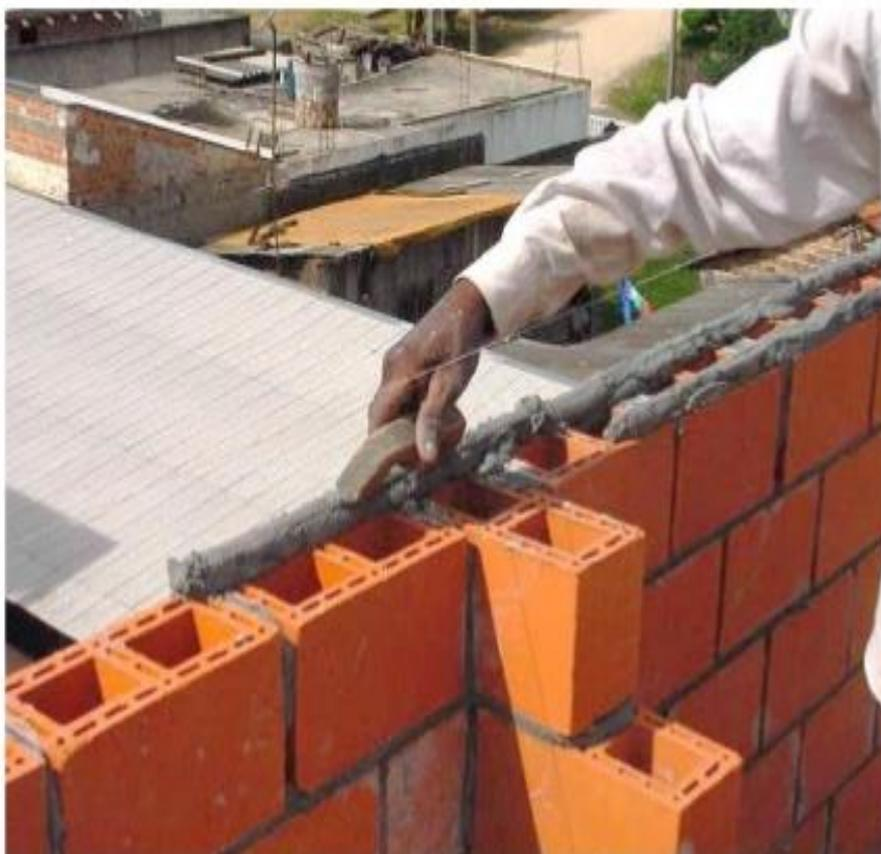
**Figura 23: Argamassa para assentamento dos blocos**
