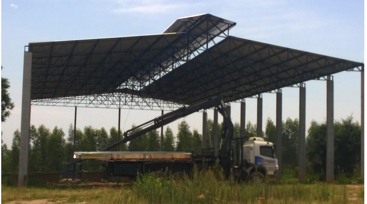
Figura 4. Exemplo de lanternim em galpão.
