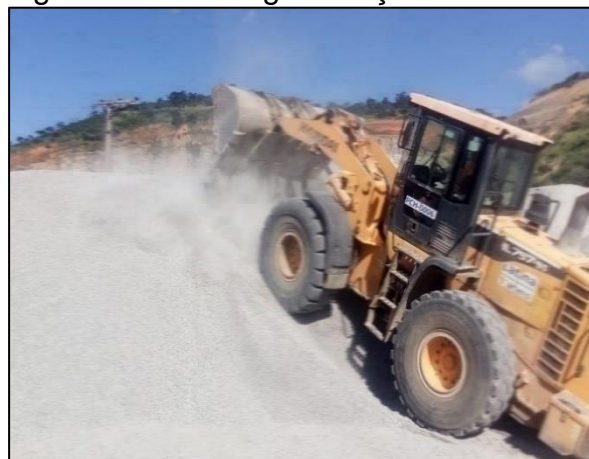
Figura 22 – Homogeneização mecânica
