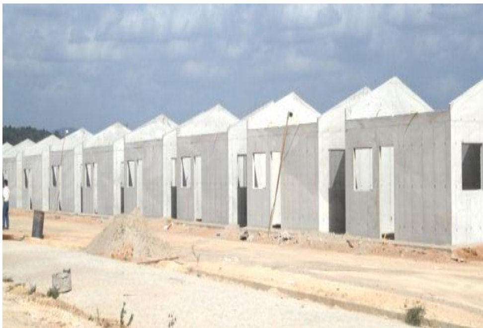
Figura 19: Sistema Construtivo de Paredes em Concreto Celular.
