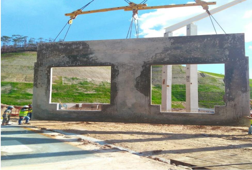
Figura 35: Painel tilt-up em pé com a ajuda do guindaste e funcionários na condução. Fonte: (O autor, 2018)
