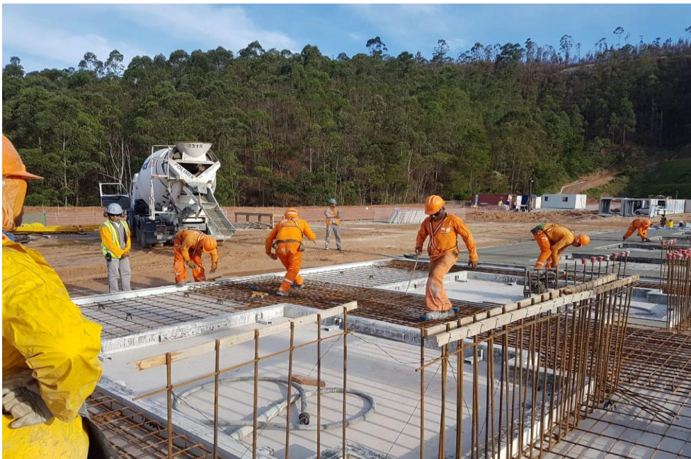
Figura 26: Armadura colocada na fôrma. Fonte: (O autor, 2018)
