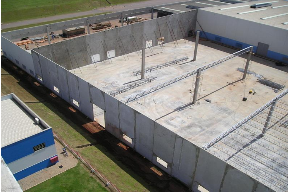
Figura 6: Painéis finalizados utilizando o tilt-up. Fonte: ( www.joharc.com.br )
