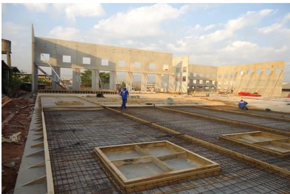
Figura 9: Parede tilt-up feita no canteiro de obras.
