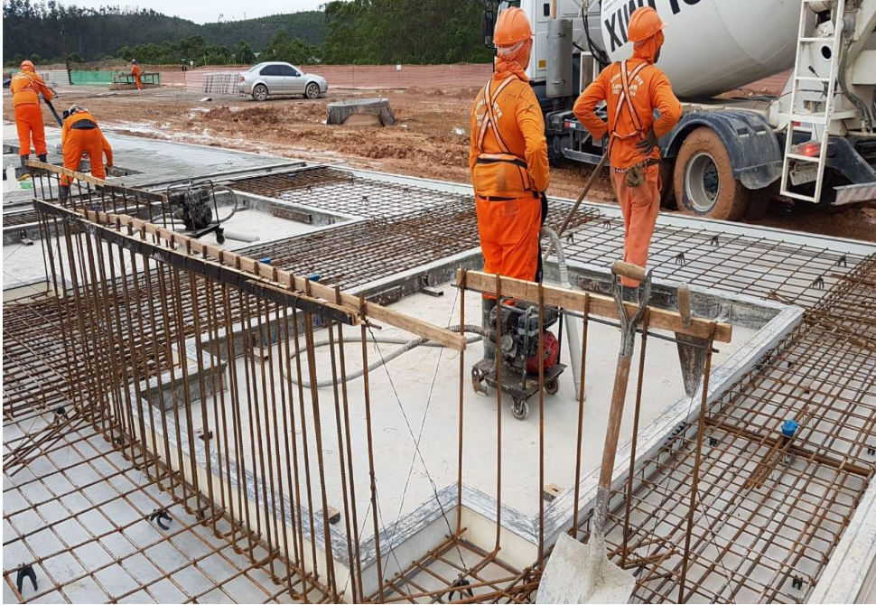
Figura 27: Armadura finalizada à espera da concretagem. Fonte: (O autor, 2018)
