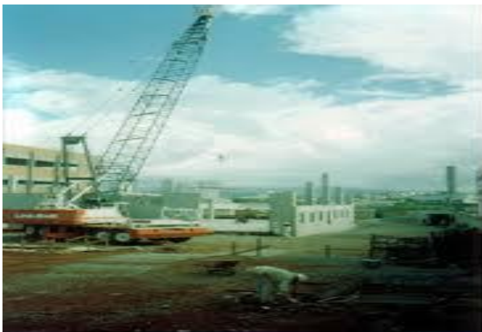
Figura 8: Guindaste na obra transportando peça Pré-Moldada Tilt-up.
