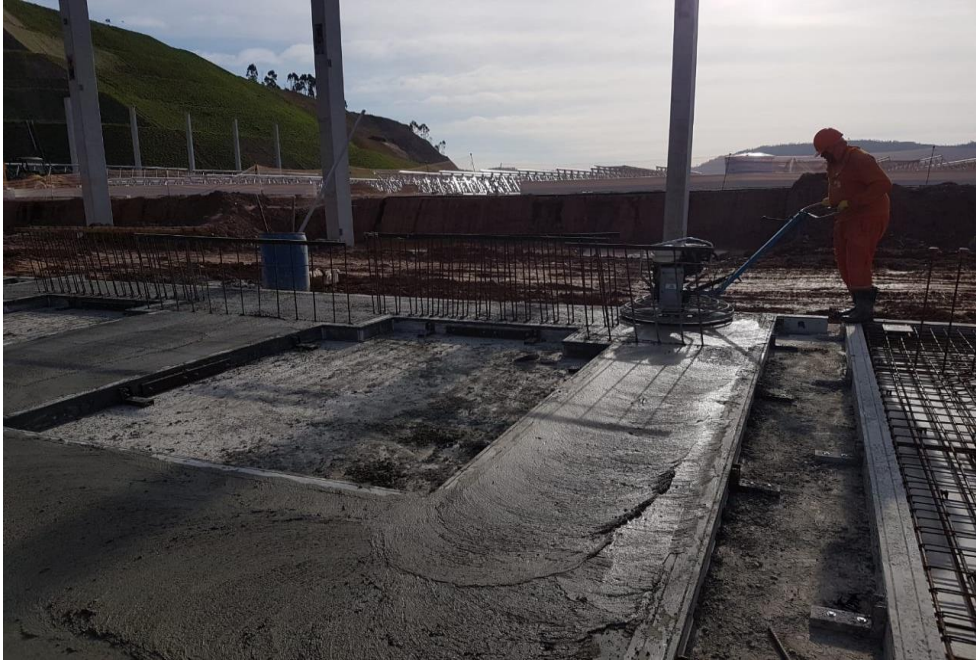
Figura 31: Deixando o painel com a superfície lisa e no nível. Fonte: (O autor, 2018)
