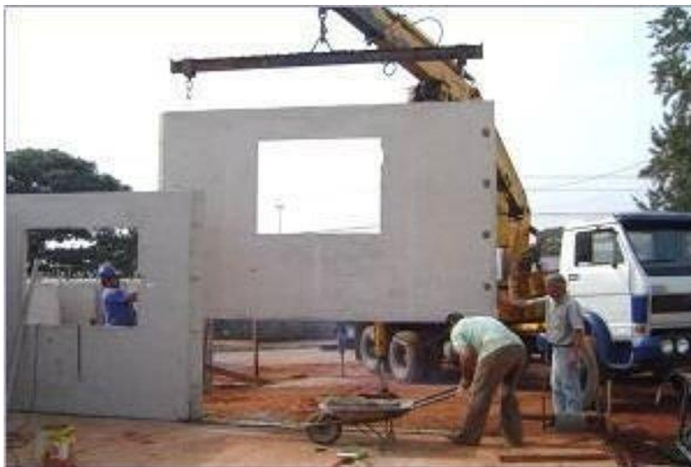
Figura 4: Parede Pré-Fabricada pronta sendo instalada na obra.
