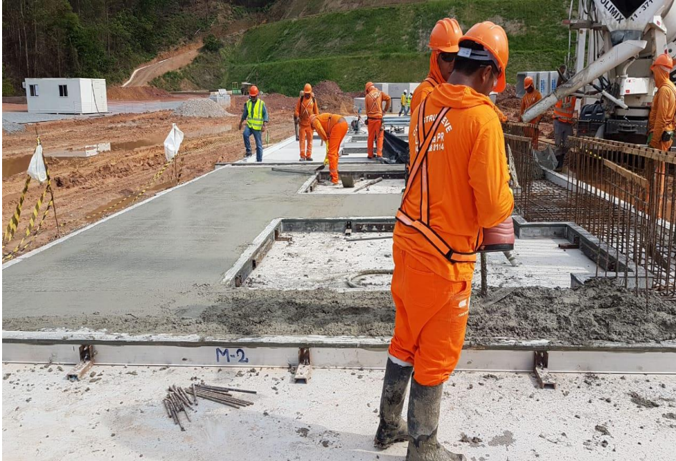
Figura 29: Finalizando a concretagem da parede tilt-up. Fonte: (O autor, 2018)
