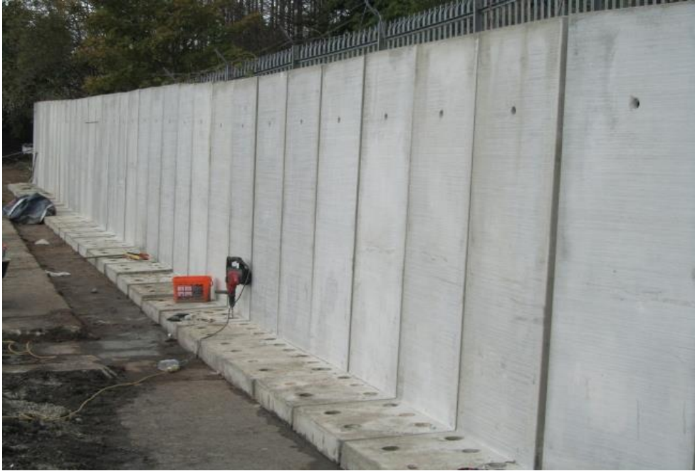
Figura 23: Painel Pré-Moldado em muro de contenção.
