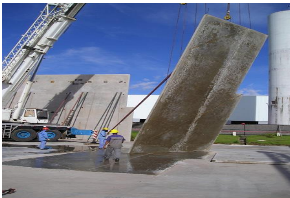
Figura 11: Guindaste auxiliando e colocando painel tilt-up no devido local.
