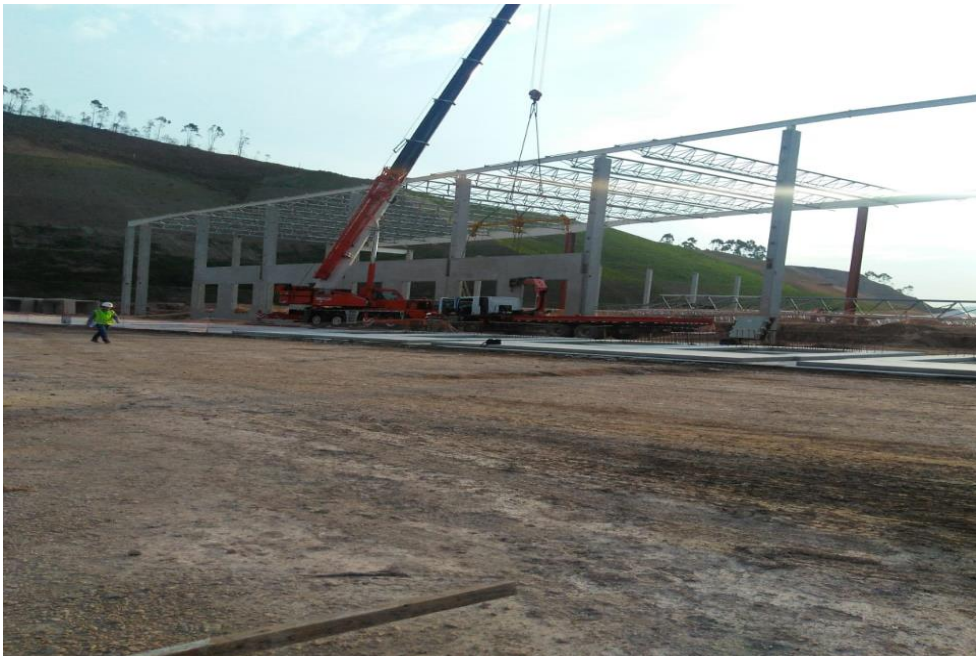
Figura 36: Painel Tilt-up finalizado e colocado na posição final da obra. Fonte: (O autor, 2018)
