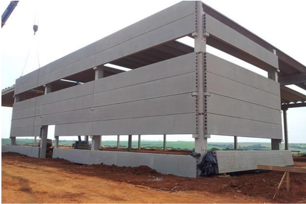
Figura 21: Pré-Moldado sendo executado no fechamento de um galpão.
