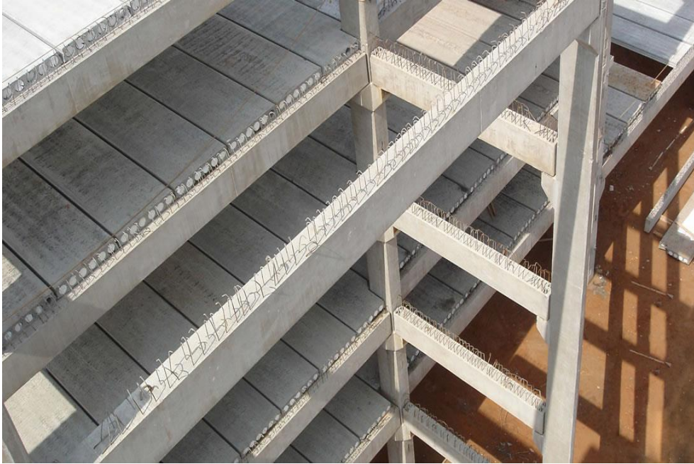
Figura 16: Laje alveolar colocada na obra. Fonte: ( www.leonardi.com.br )
