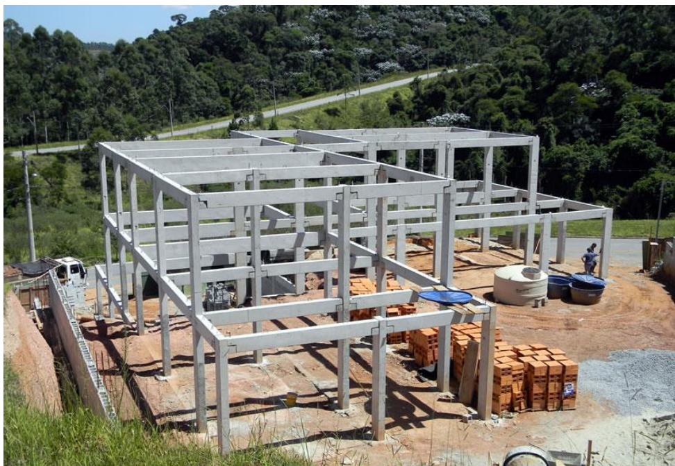
Figura 15: Sistema esqueleto Pré-Moldado. Fonte: ( www.lajes.com.br )
