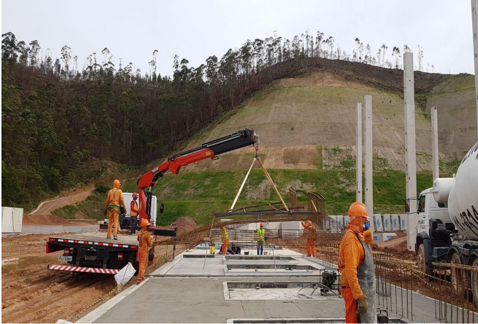
Figura 25: Início da montagem da armadura. Fonte: (O autor, 2018)
