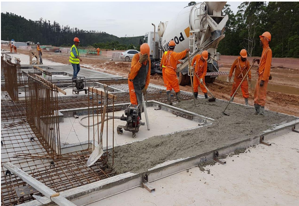
Figura 28: Concretagem da armadura na fôrma. Fonte: (O autor, 2018)
