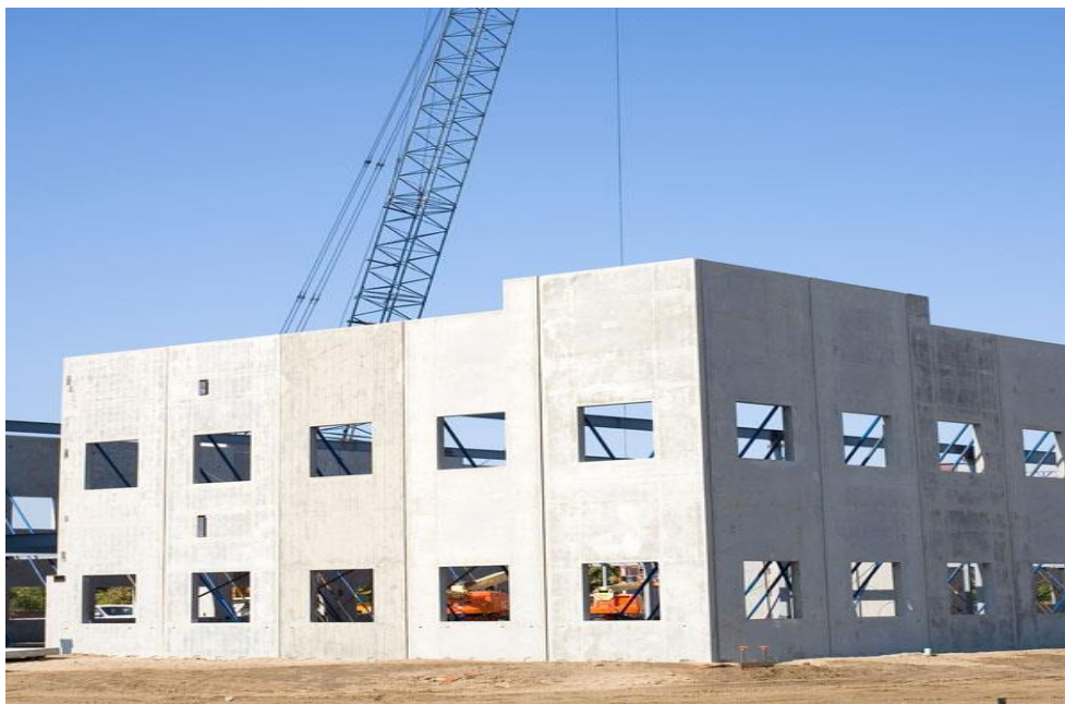
Figura 10: Painel tilt-up totalmente instalado na obra.
