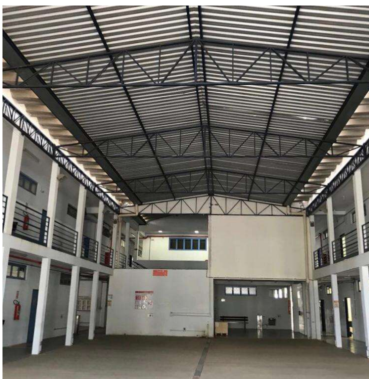
Figura 4 – Imagem do Sistema de cobertura do pátio do Bloco 2.
