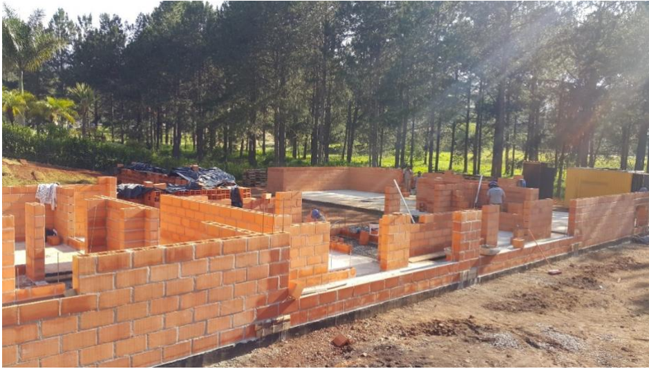
Figura 23, Paredes com os cantos sempre sem blocos quebrados, Fonte: O autor (2018)
