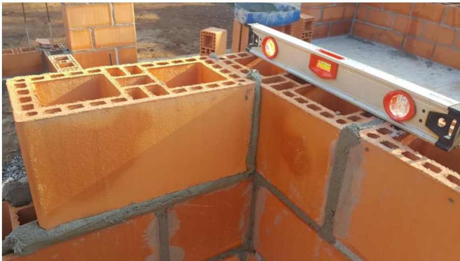
Figura 22, Paredes niveladas com o nível de mão, Fonte: O autor (2018)
