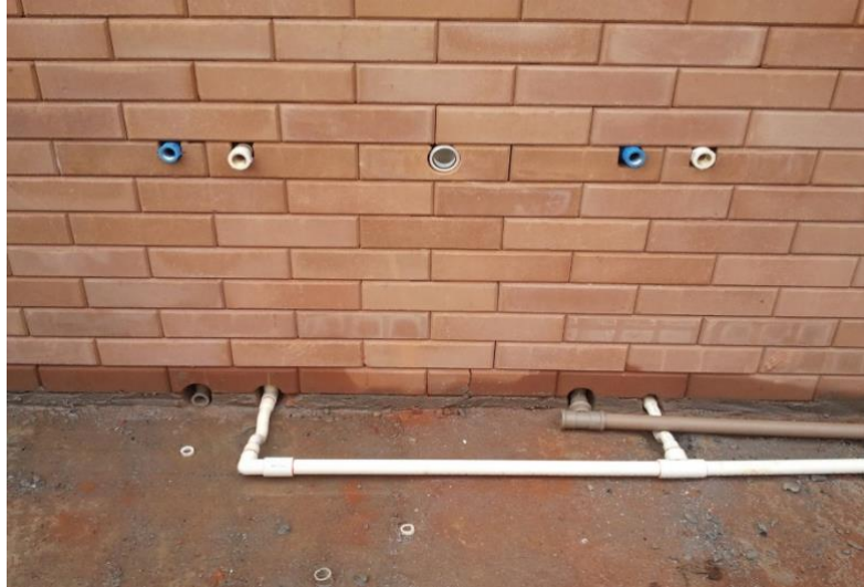
Figura 12, instalação hidráulica, Fonte: https://www.tijolosolocimento.com.br (2018)
