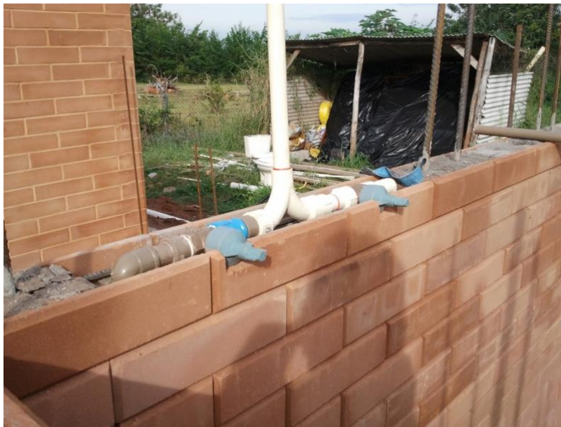
Figura 13, instalação hidráulica, Fonte: https://www.tijolosolocimento.com.br (2018)
