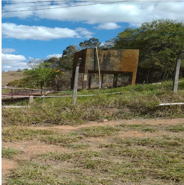
Figura 17- Reservatório de lavagem dos filtros 12000 L.
