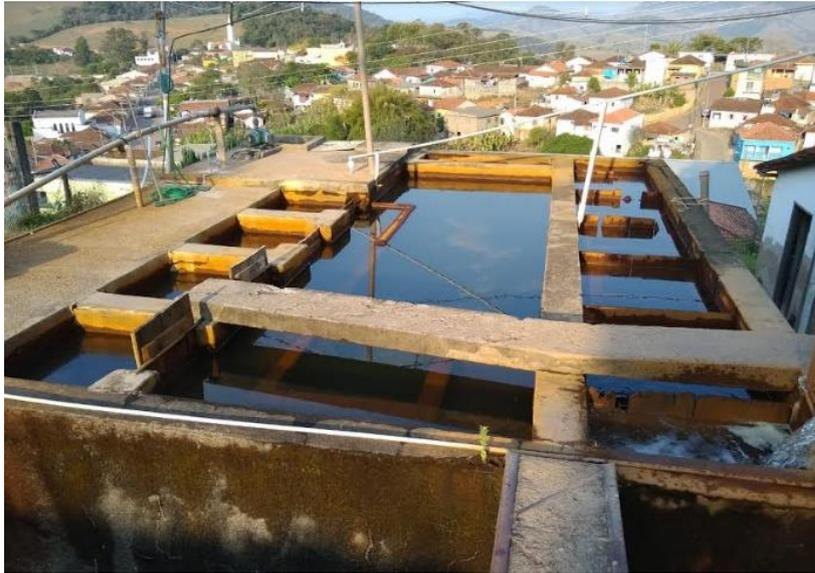
Figura 15- Setor de floculação, decantação e filtragem da água.
