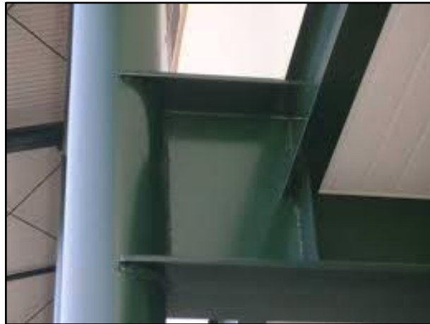
Figura 9: Ligação Soldada.
