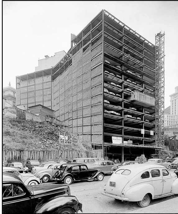
Figura 3: Edifício Garagem América.
