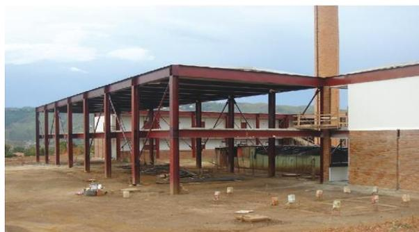
**Figura 4:** Canteiro de obras de uma edificação com estrutura de aço
