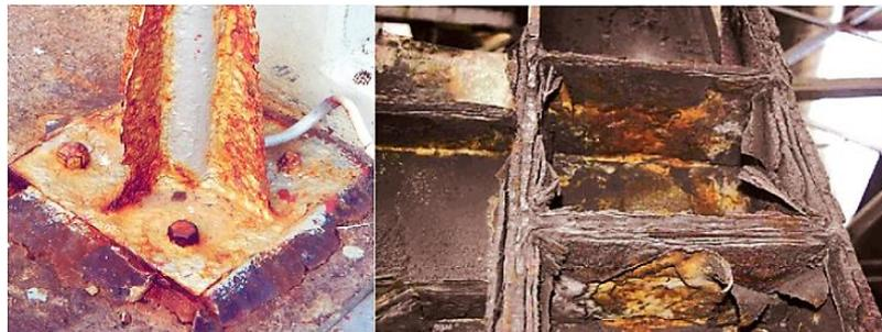
**Figura 6:** Exemplos de corrosão de grande intensidade
