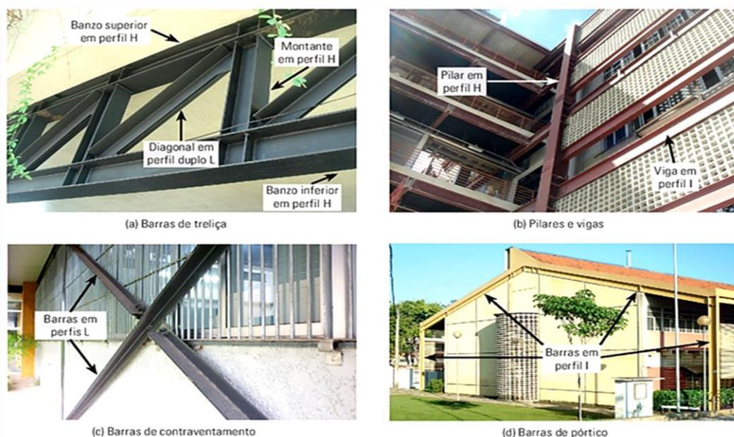
**Figura 1:** Exemplo de elementos estruturais de aço
