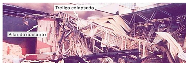
**Figura 9:** Colapso de treliças de uma cobertura causado por incêndio
