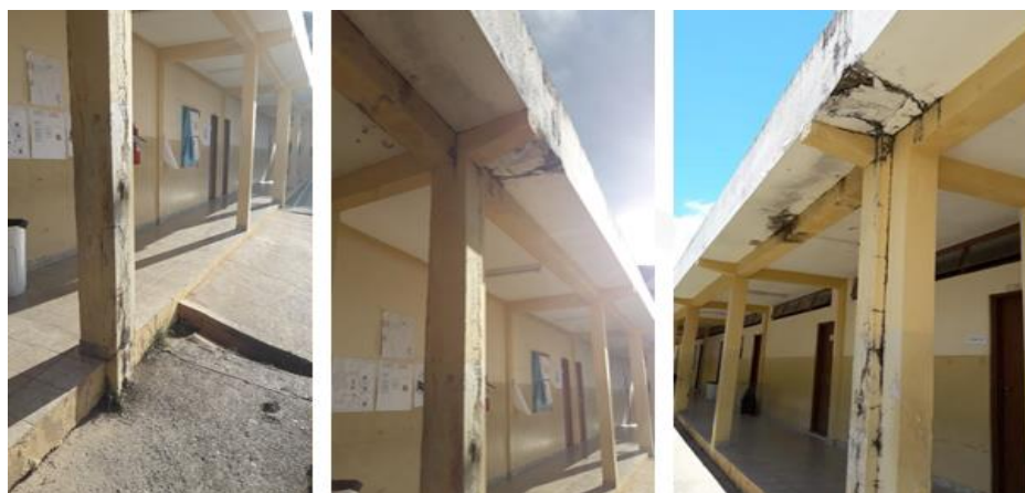
Figura 13- Pilares da escola Evandro Brito da Cunha
