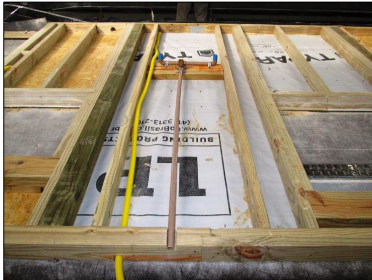
Figura 7 - Instalação elétrica e Hidro sanitária no sistema wood frame
