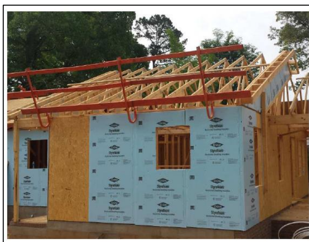
Figura 5 - Camada de impermeabilização da estrutura com painéis
