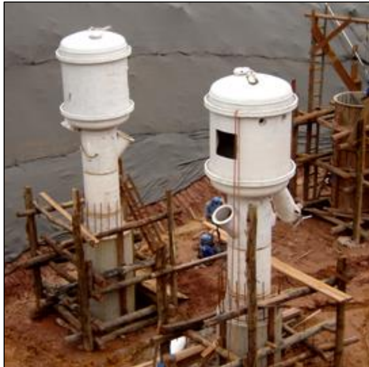
Figura 9 - Tubulão a ar comprimido
