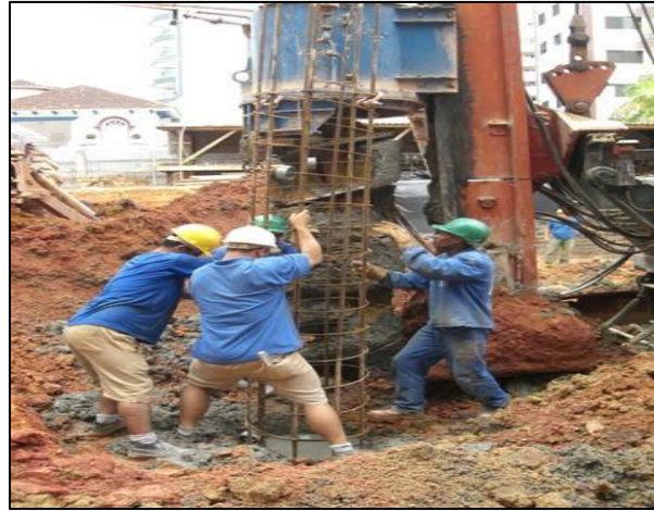
Figura 17 - Introduzindo a armadura.
