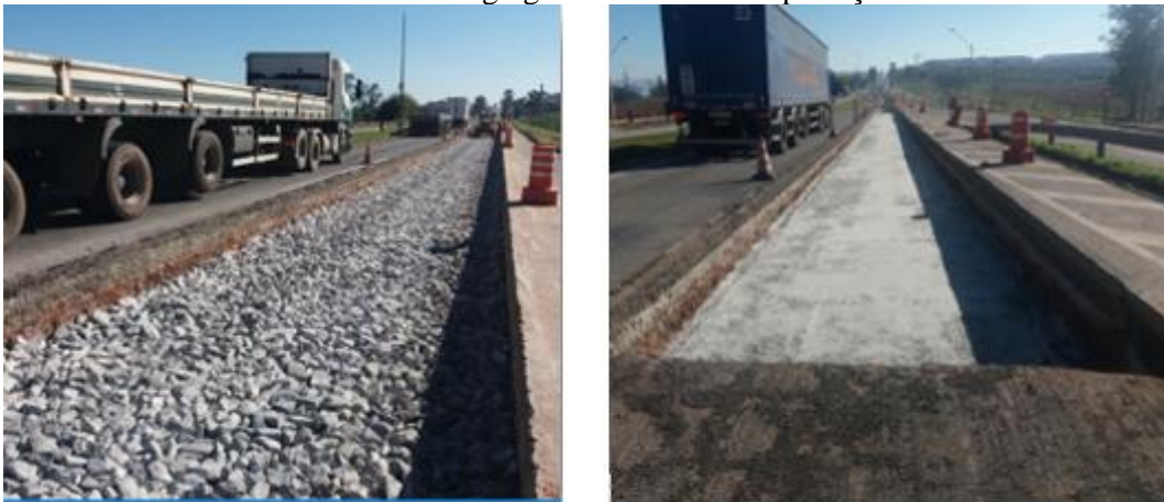
Figura 26 – Lançamento de 1ª camada de Macadame Seco (Rachão) / camada de enchimento, constituída de agregados miúdos / compactação
