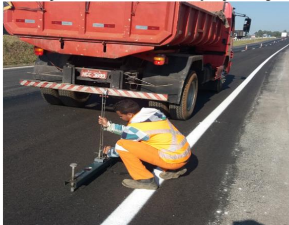
Figura 33 – Pintura nas faixas do pano executado e verificação pela Viga Benkelman
