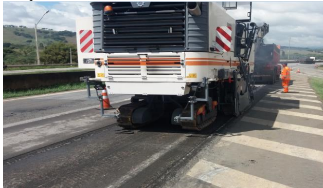
Figura 14 – Microfresagem do pavimento
