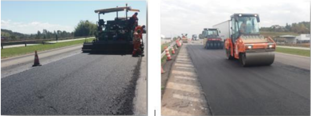
Figura 32 – 2ª e 3ª Camadas CBUQ / Compactação
