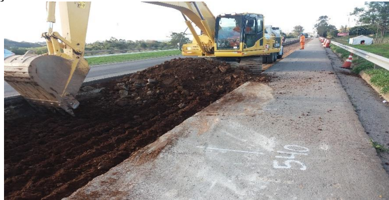
Figura 24– Remoção Mecanizada
