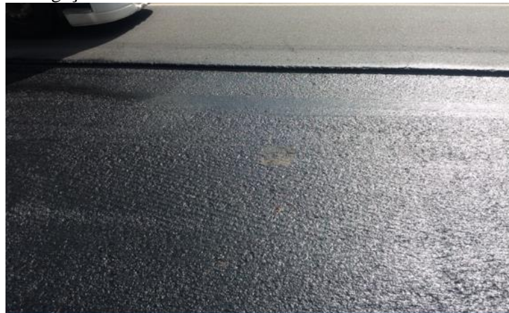
Figura 30– Pintura de Ligação
