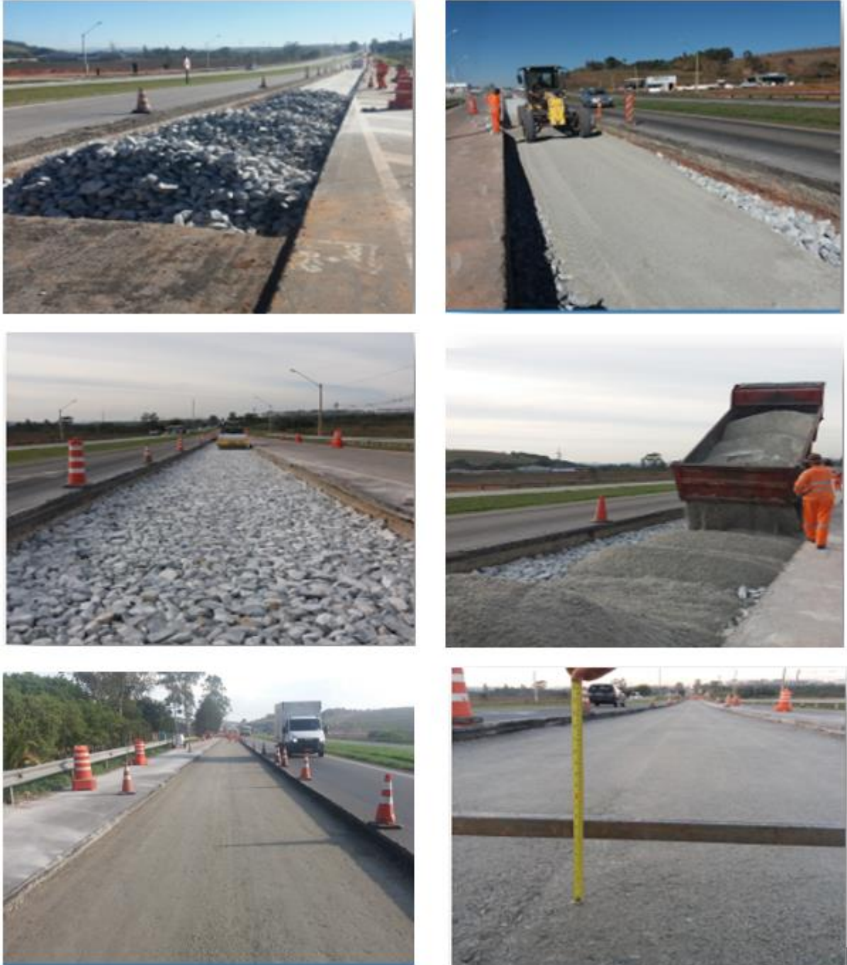
Figura 27 – Lançamento de 2ª e 3ª camadas de Macadame Seco (Rachão) / – Base de BGS (camada de enchimento, constituída de agregados miúdos)
