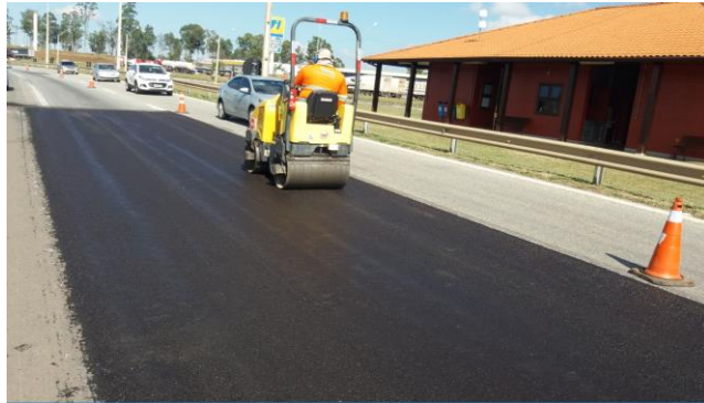
Figura 15 – Compactação do micro revestimento
