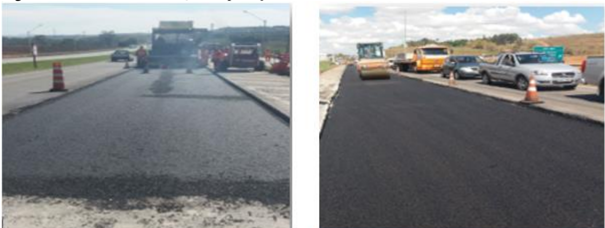
Figura 31 - 1ª Camada CBUQ / Compactação
