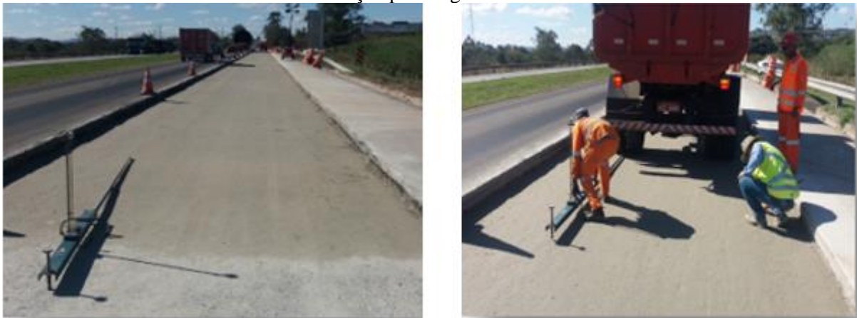
Figura 28 – Base de BGS (camada de enchimento, constituída de agregados miúdos) / compactação e verificação pela Viga Benkelman.
