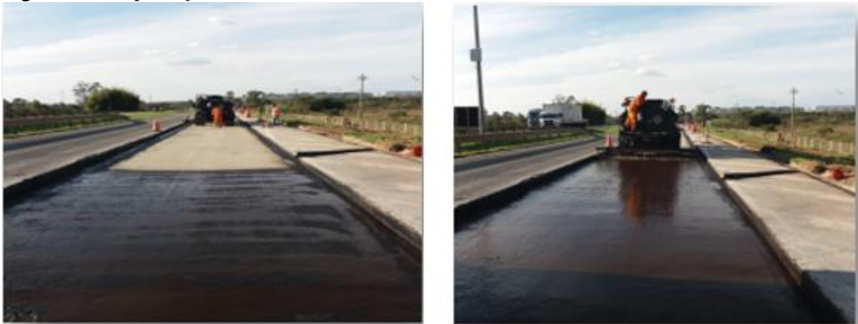
Figura 29 – Imprimação Asfáltica
