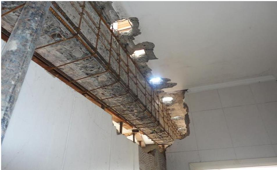
Figura 5 - Reforço da armadura positiva e transversal da viga
