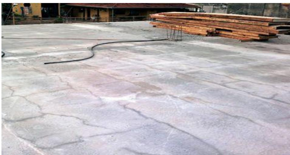
Figura 3 - Laje com fissuras causada pela retração do concreto
