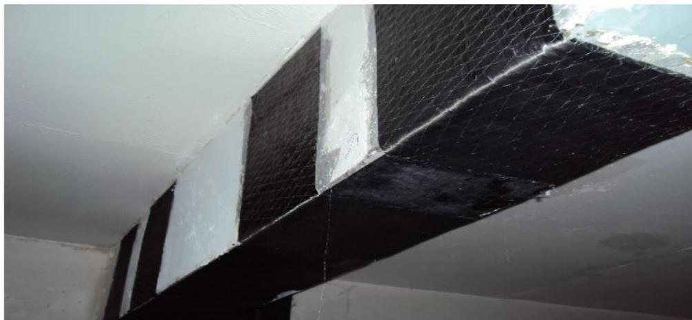
Figura 11 - Viga utilizando a fibra de carbono como reforço
