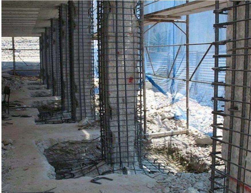
Figura 8 - Reforço transversal em um pilar (encamisamento)
