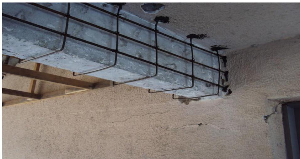
Figura 4 - Reforço transversal na viga
