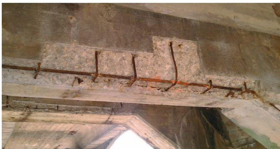
Figura 2 - Estrutura degradada e armadura parcialmente corroída
