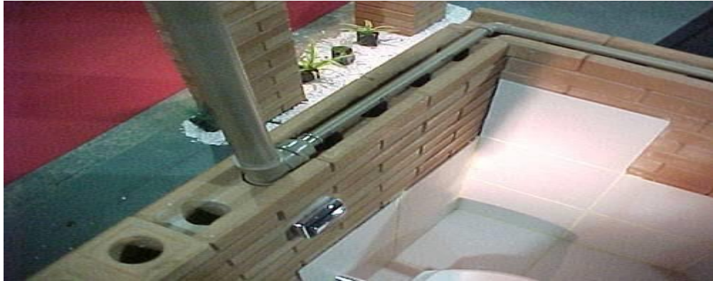
Figura 28: Instalações hidráulicas em alvenaria solo-cimento. Fonte: Hidroshow e Hidroshow.(2011).
