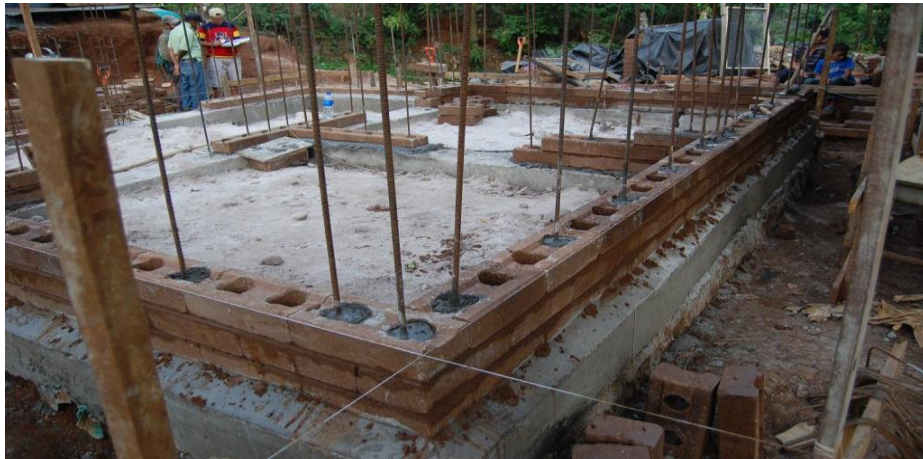
Figura 26: Processo de execução em alvenaria solo-cimento Fonte: Engineeringforchange.org.
