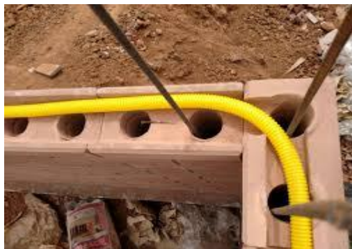
Figura 27: Instalações elétricas em alvenaria solo-cimento. Fonte: Mach blocos.
