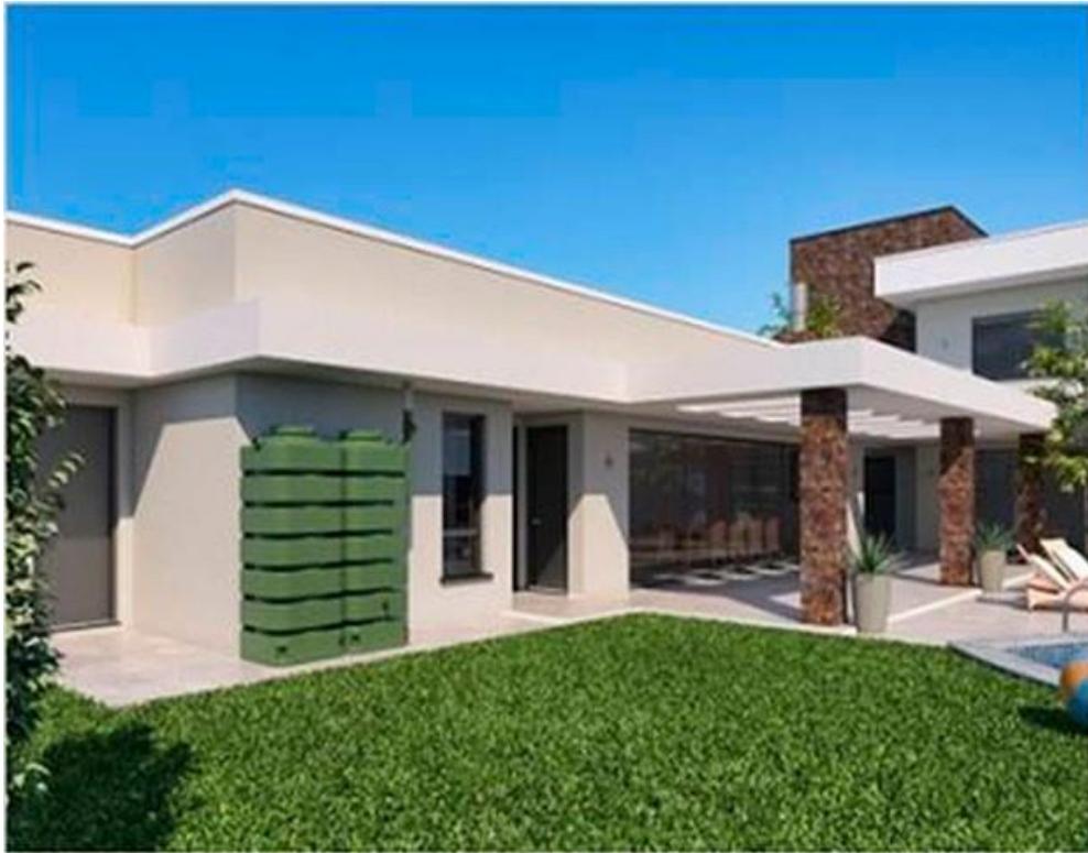
Figura 19: Residência com cisterna 1050 litros. Fonte: Tecnotri.(2016).
