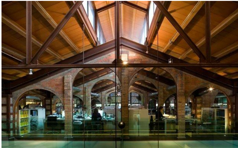
Figura 4: Iluminação natural utilizando Lanternim. Fonte: laboratoriodeconfortocau.blogspot.com.br.
