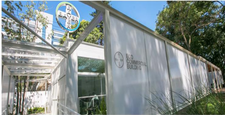
Figura 22: Eco Commercial Building (ECB), em São Paulo. Fonte: Constructapp.(2016).
