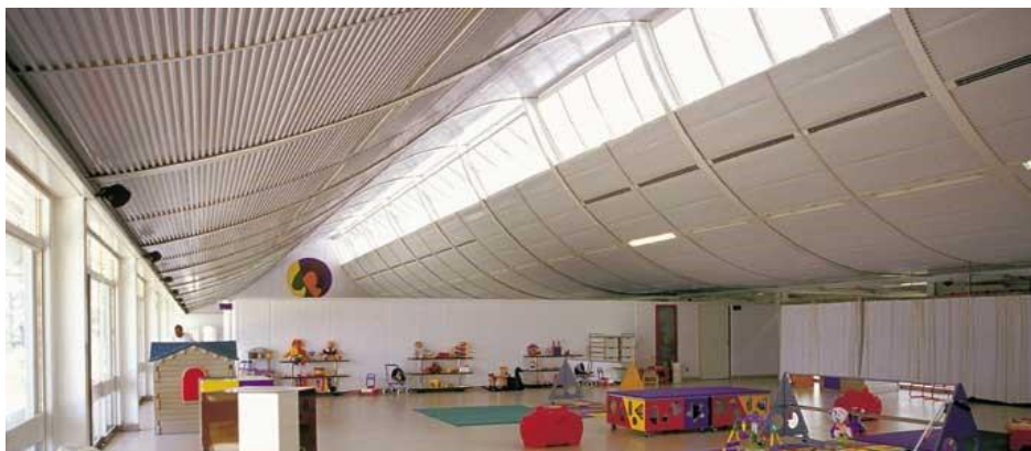
Figura 3: Iluminação natural utilizando Shed. Fonte: arcoweb.
